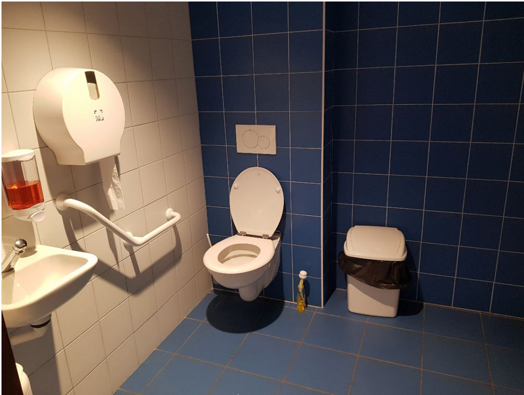
h) Photos des toilettes PMR du rez-de-chaussée
