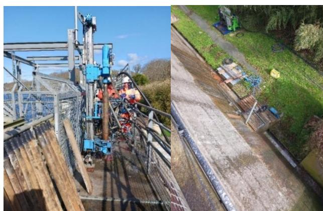
Les résultats d'analyses piézométriques et les investigations sur le béton du barrage réalisées ont conduit à un rapport rassurant sur l'état de l'édifice.
