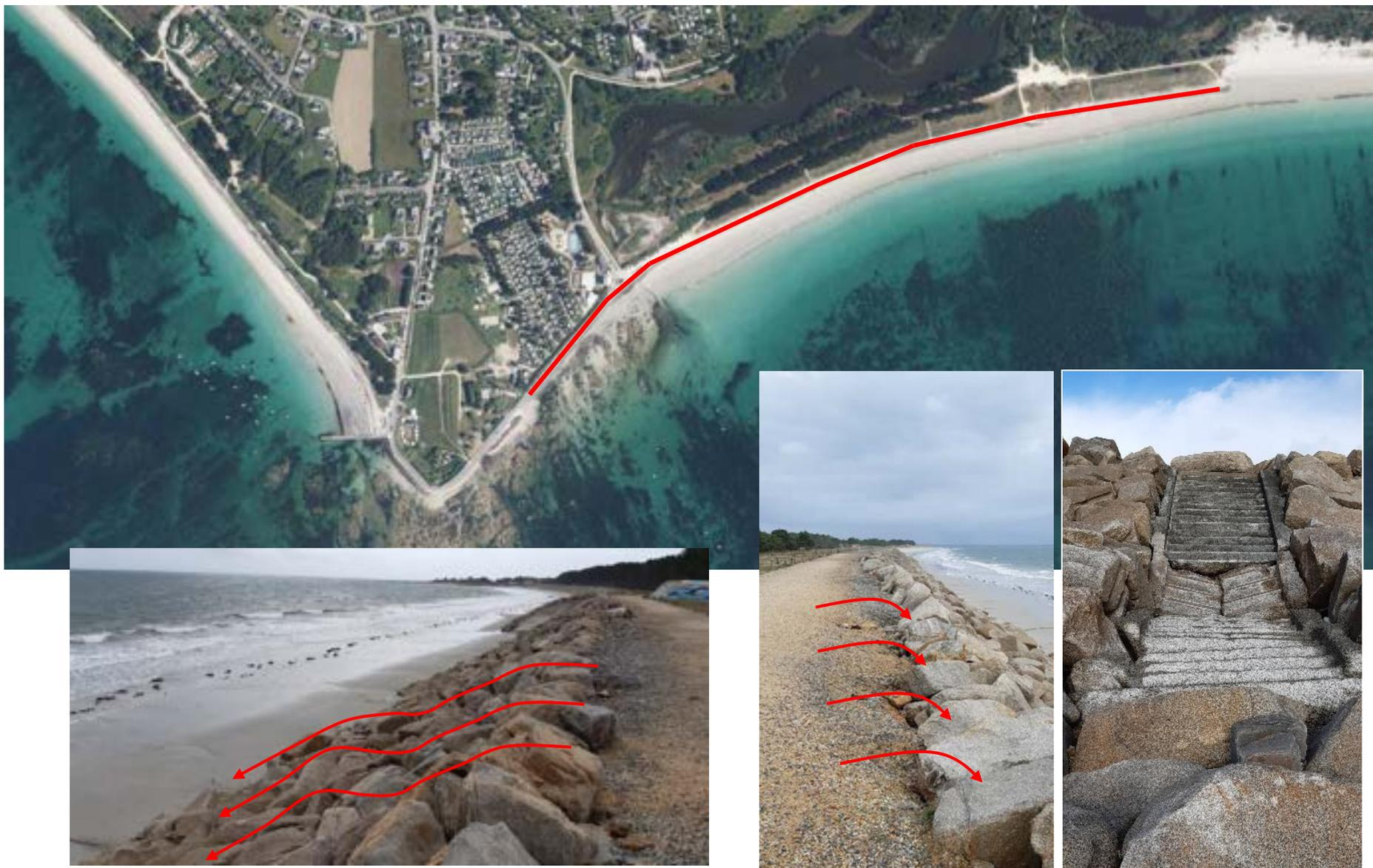
Figure 53 – Désorganisation, affaissement et soutirage des matériaux de l'encrochement du système d'endiguement de Mousterlin Ouest, et exemple de dégradation visible sur un escalier
