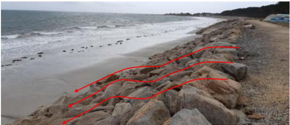
Figure 79 – Désorganisation et affaissement du linéaire d'enrochement de Moustierlin Ouest
